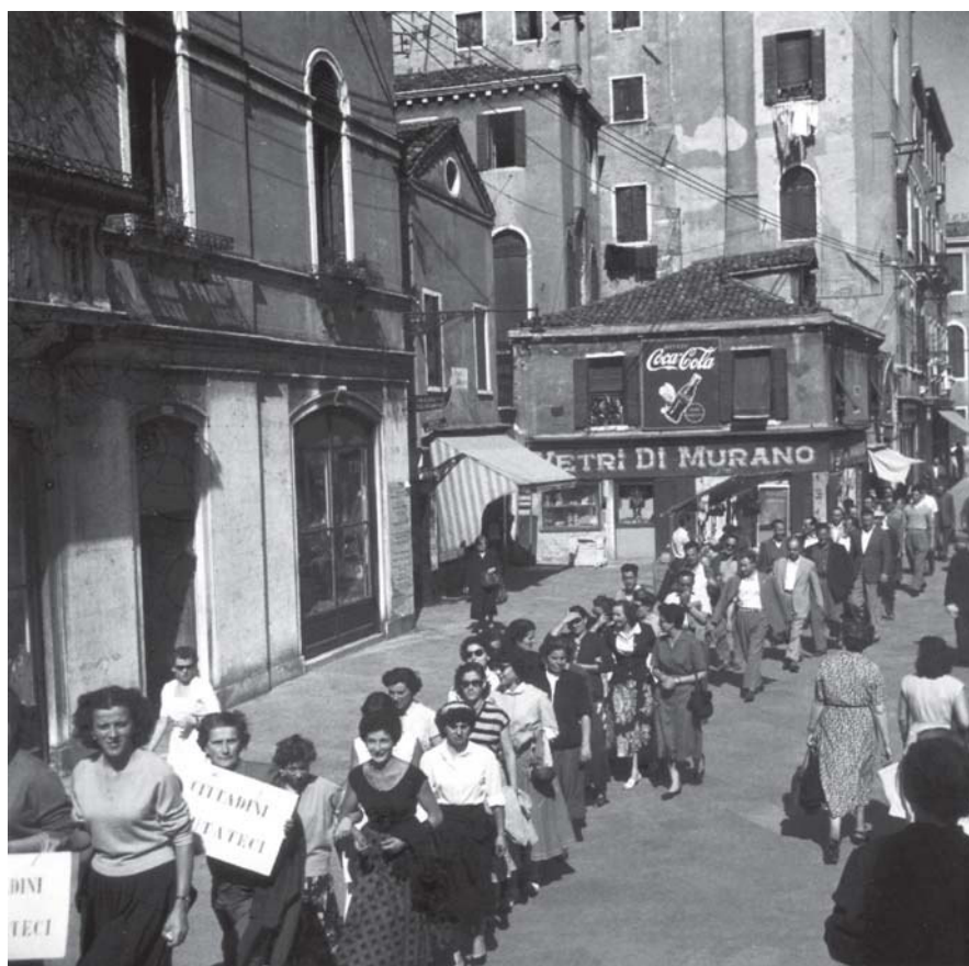
Corteo delle maestranze dello Stucky a San Felice (Strada Nova)
